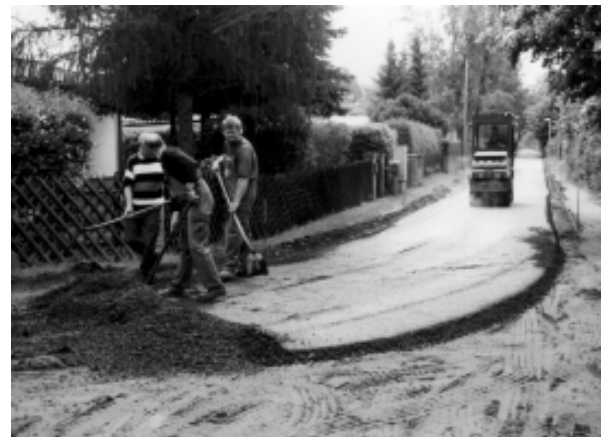
Im Mai Straßenbau am Zernsee
